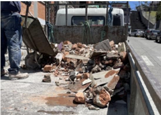
El ladrillo artesanal denominado “panelón” es el más utilizado en las construcciones de la ciudad de Cuenca, y su principal producción proviene de las fábricas del sector Racar en la ciudad de Cuenca, y por sus propias condiciones de fabricación, la cocción no es uniforme, existiendo varios matices, como lo podemos apreciar en la figura 13.
