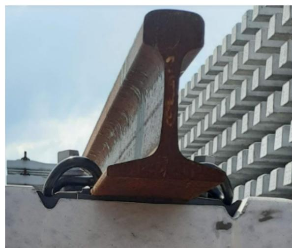
En relación con el ancho de la trocha, la cual corresponde a la distancia entre las caras internas de los dos rieles que conforman la vía, medida a 14 mm por debajo de la superficie (o plano) de rodadura del carril. Para el caso de la Red Férrea del Pacífico, el ancho de trocha empleada es la denominada “estrecha”, “angosta” o “yarda”
