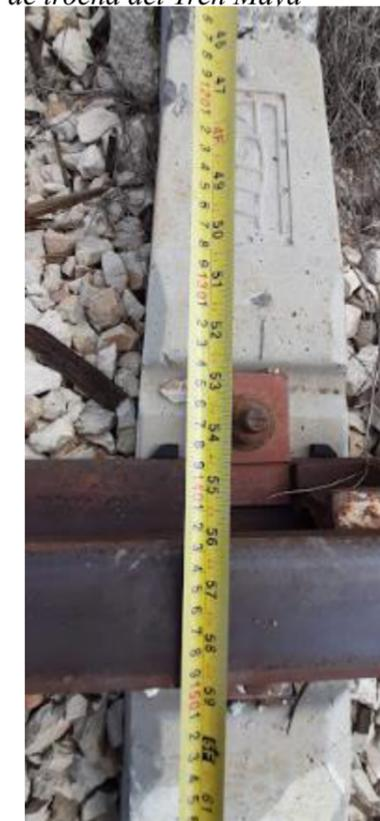
Las traviesas empleadas en el trazado de la Red Férrea del Pacífico que se encontraron fueron traviesas de madera (polines) y traviesas de concreto, las cuales miden 190 cm de largo. Las traviesas de madera se encuentran en deterioro por falta de mantenimiento y cuidado, restándole estabilidad a la vía y convirtiéndose en un factor de riesgo de descarrilamiento o volcamiento.
